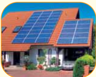
Aufdachanlage 6,36 kWp
