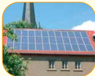
Indachanlage 6,19 kWp
