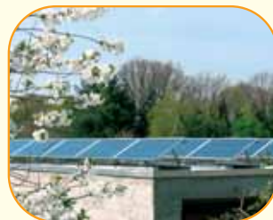
Flachdachanlage 5,5 kWp
